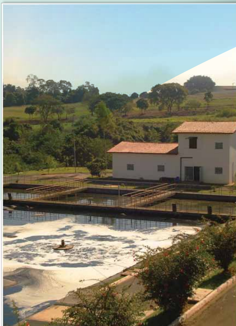
Estação de tratamento de esgoto. MARCELO MAZZOLA
